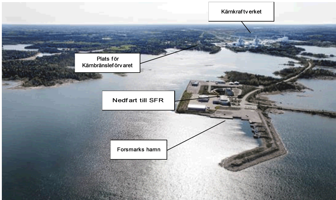
Figur 3-3. Forsmarks hamn, SFR och Forsmarks kärnkraftverk.
