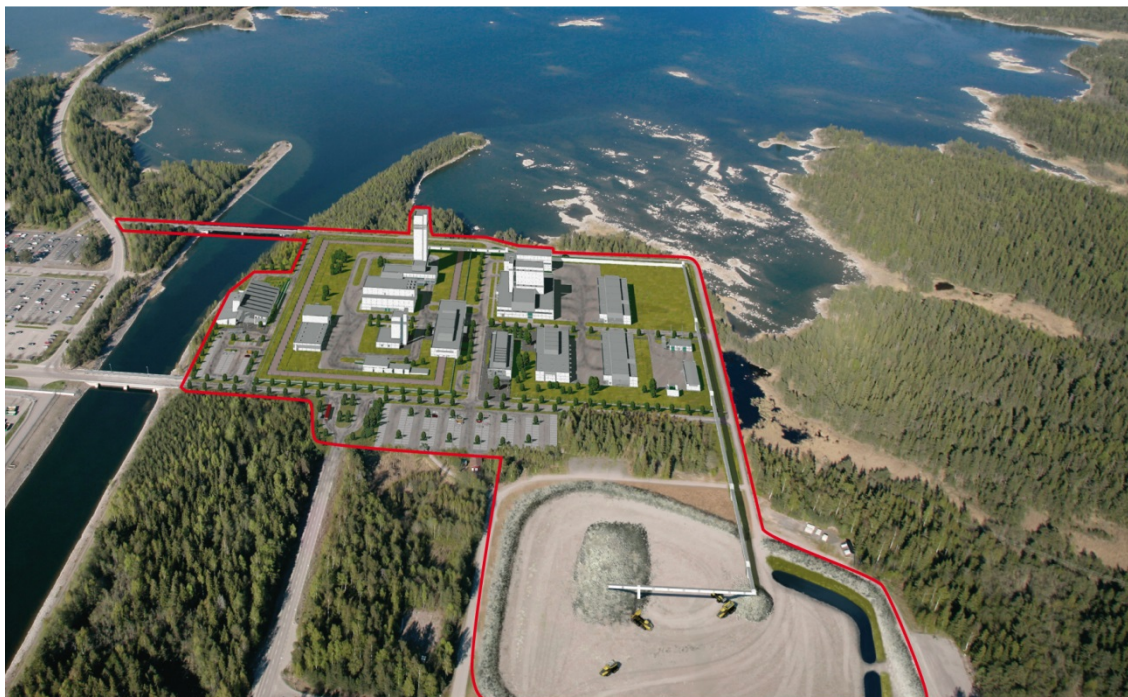
Figur S-7. Slutförvarsanläggningens placering vid Söderviken i Forsmark (fotomontage). Forsmarks kärnkraftverk skymtar till vänster i bilden och ytan längst ner är bergupplaget. De röda markeringarna anger vad som är fotomontage.
