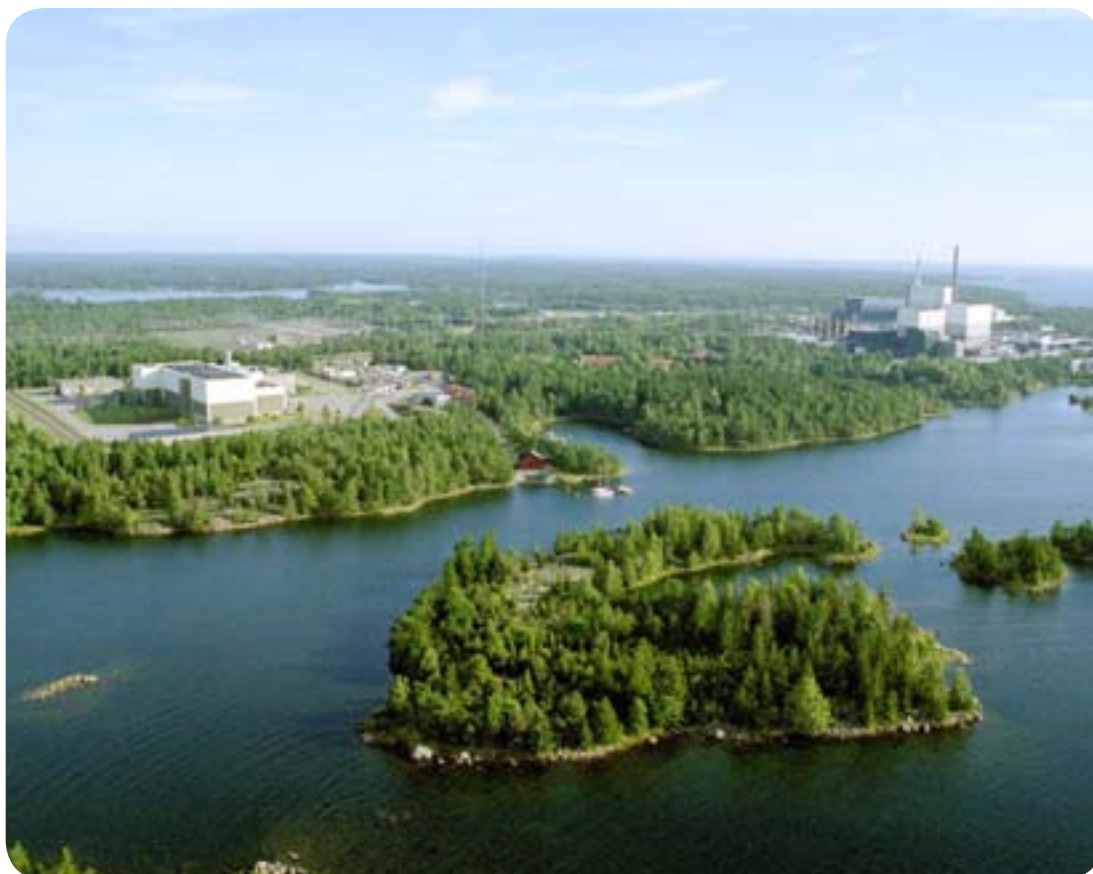
Figur 7-43. Flygfoto av Simpevarpsöarna. En zon av hällmarkstallskog har lämnats nära stränderna för att skärma av den storskaliga kraftindustrin mot omgivande kulturmiljöer.
