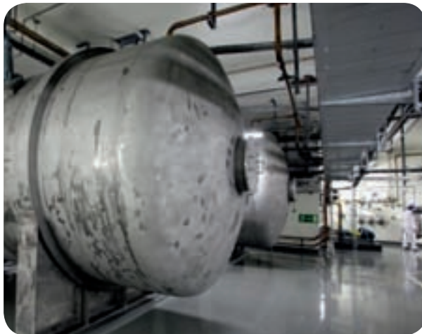
Figur 8-4. Uppsamlingsstankar för processvatten på Clab.
