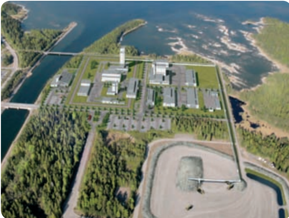
Figur 10-16. Fotomontage av den färdiga anläggningen.
