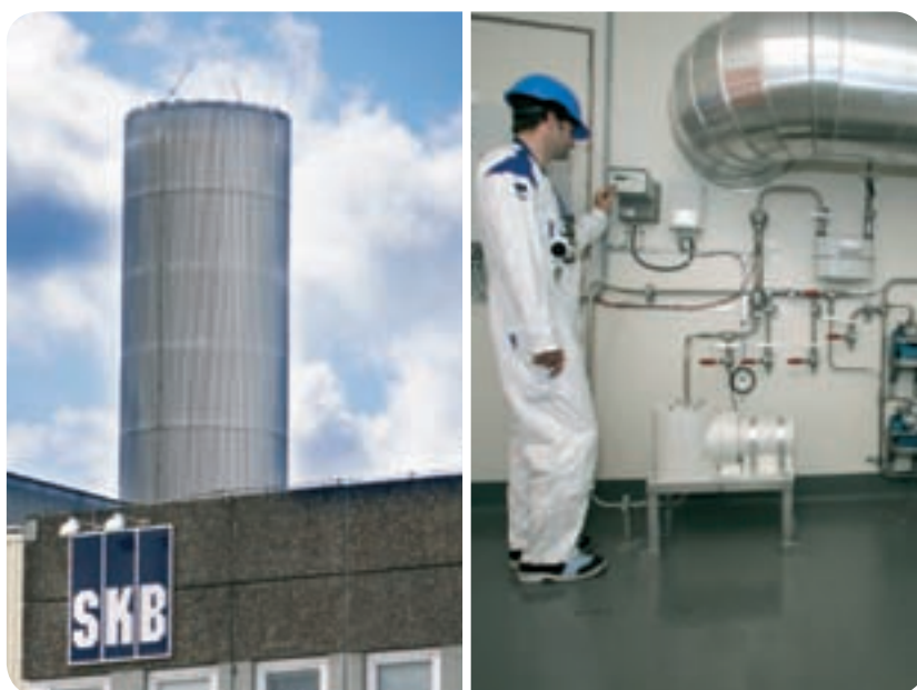
Figur 8-15. Clabs ventilationsskorsten och mätutrustning för aktivitetsutsläpp till luft.
