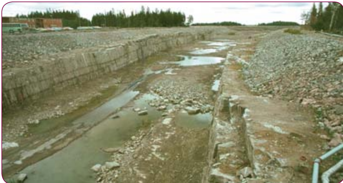
Figur 7-11. Exempel på hur de horisontella, vattenförande sprickorna i sprickdomän FFM02 ser ut nära ytan. Foto taget vid anläggandet av kylvattenkanalen i Forsmark.
