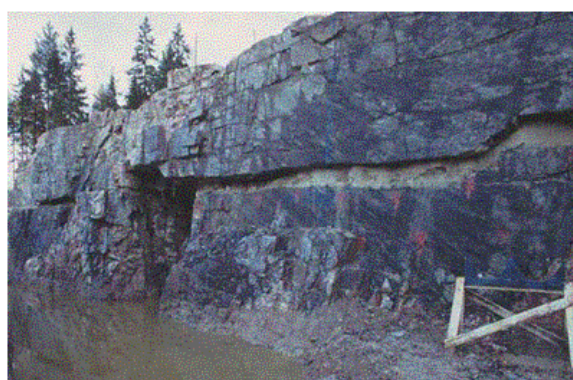
Inloppskanal till kraftverket
