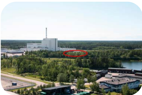
Inkapslingsanläggning i Forsmark
