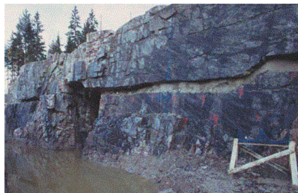
Inloppskanal till kraftverket
