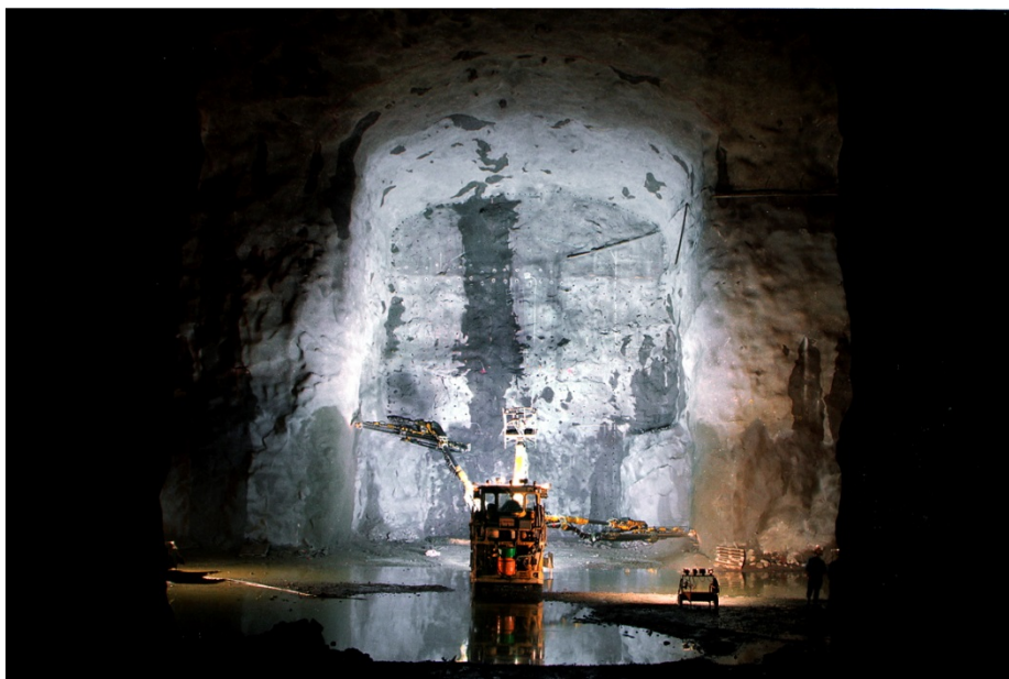
Figur 4-6. Utbyggnaden av Clab etapp 2.
