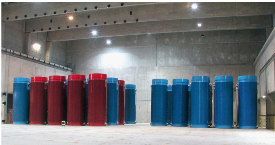
Figur 4-7. Castor-behållare för torr mellanlagring i lagringsbyggnad vid Gorleben i Tyskland. Behållaren uppfyller också kraven på att kunna transporteras.
