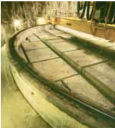
Huvuddelen av radioaktiviteten i anläggningen finns i silon.
