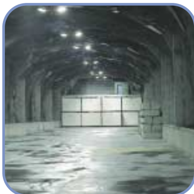
Betongkokiller med medelaktivt avfall i SFR.
